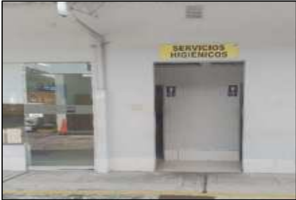
Vista fotográfica N° 8: Servicios higiénicos.
